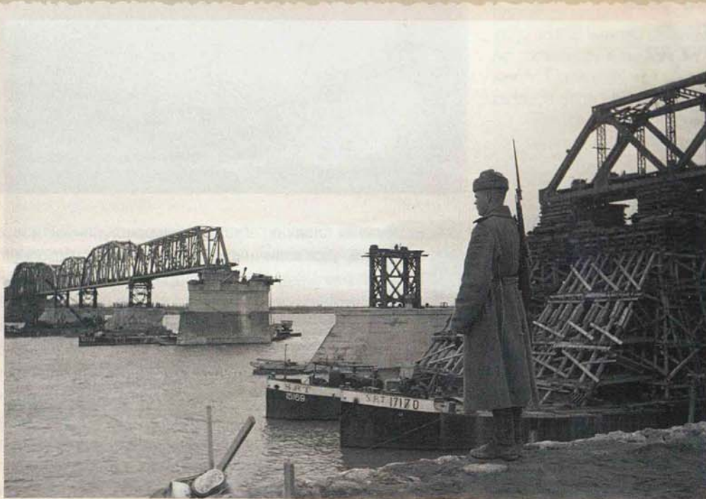
Изградња Панчевачког моста 1946. године
